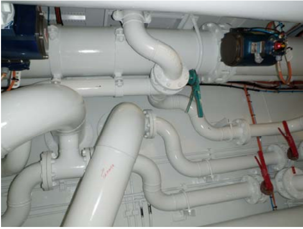
Bilde 4 og 5: Utvendig inspiserbare sirkulasjonsrør Båt 1.
