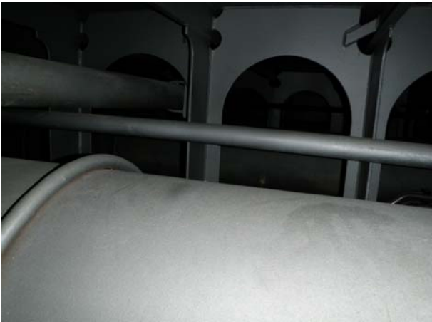
Bilde 6 (v) og 7(h): Sirkulasjonsrør Båt 2, rør ligger i eget krypdekk ca 1,5 meter høyt.
