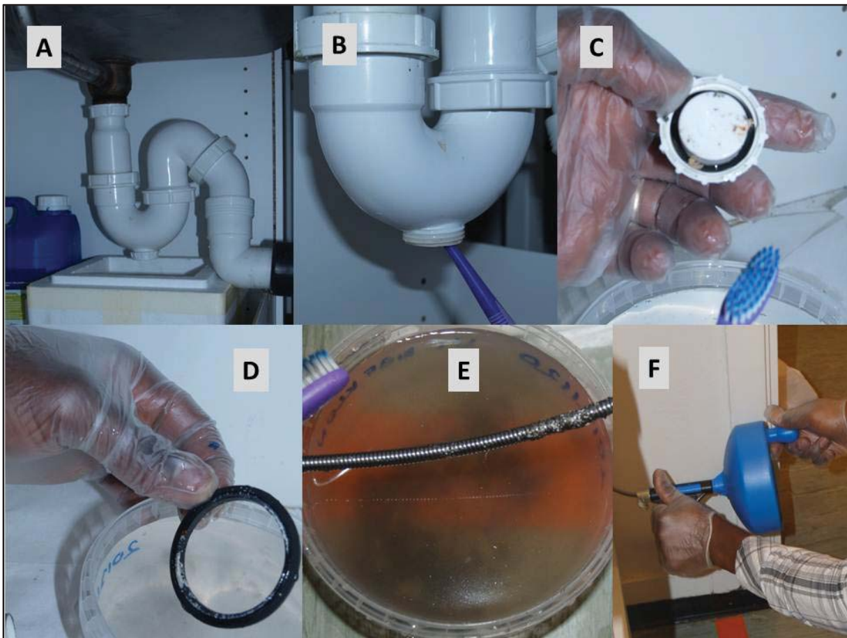
Figur 2. Prøvetaking. A) Representativ vask med vannlås. B) Etter fjerning av proppen til vannlåsen ble all væske i vannlåsen samlet opp og deretter ble biofilmen i vannlåsen samlet med tannbørste. C) Også proppen ble børstet slik at biofilm på proppen ble tatt vare på. Legg merke til gulhvite klumper av biofilm på proppen. D) Det sitter ofte en del biofilm på gummipakninger i vannlåser og rørskjøter (gråhvitt slim). E) Biofilm festet seg forholdsvis godt i og mellom spiralringene i stakefjæren (grålig slam). F) Stakefjær med pistolgrep som gjør det mulig å rotere stakefjæren opptil 7 meter nede i avløpsrøret.
